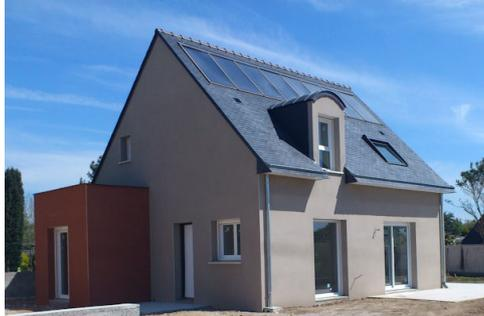
C'est une petite maison simple, bâtie en briques creuses, isolée intérieurement avec 14 cm d'isolant sur les murs et 20 cm dans les combles. Les fenêtres sont à double vitrage...
